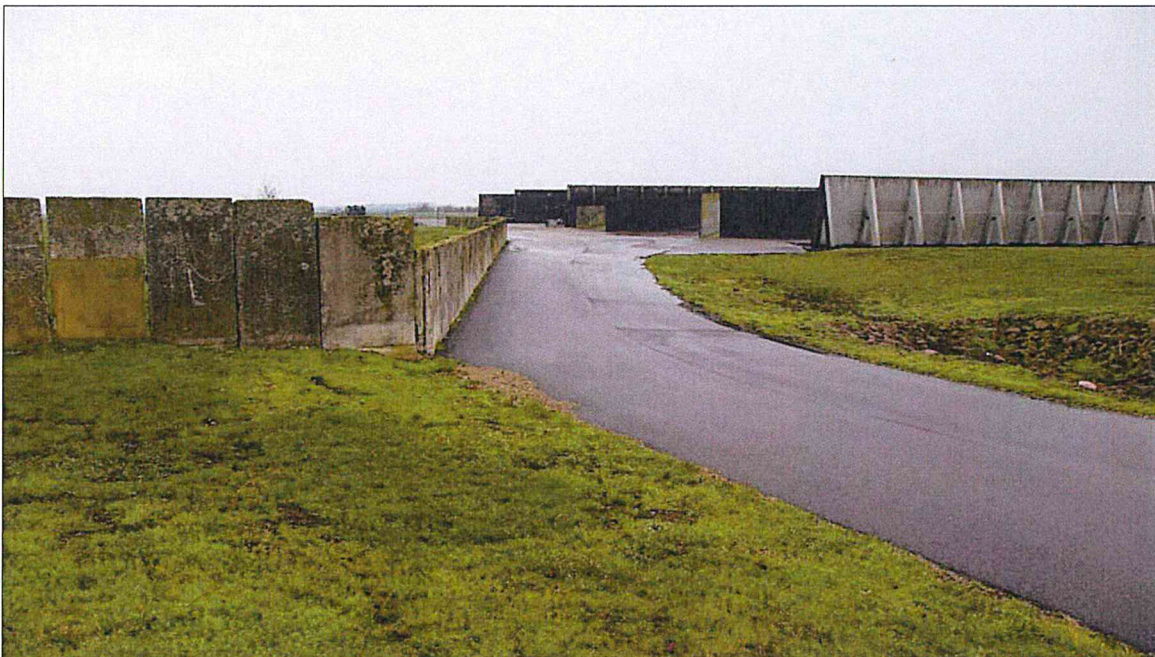
Nordgrenze mit alten und neuen Durchfahrtsilos, Blick nach Osten.
