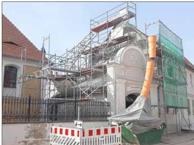
Nach den winterlichen Temperaturen ist es nun dem Museum Synagoge Gröbzig möglich, die Bauarbeiten am Gebäude fortzuführen. Zunächst wird der einsturzgefährdete Giebel saniert, bevor die Arbeiten am barrierefreien Zugang weiter vorangetrieben werden.
